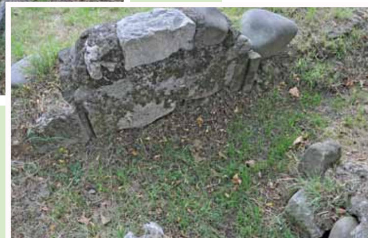
A destra: Ripartitore dell'acqua prelevata, si notano, ricavate, nelle pietre gli inserti della usciera per la chiusura del canale irrigatorio
